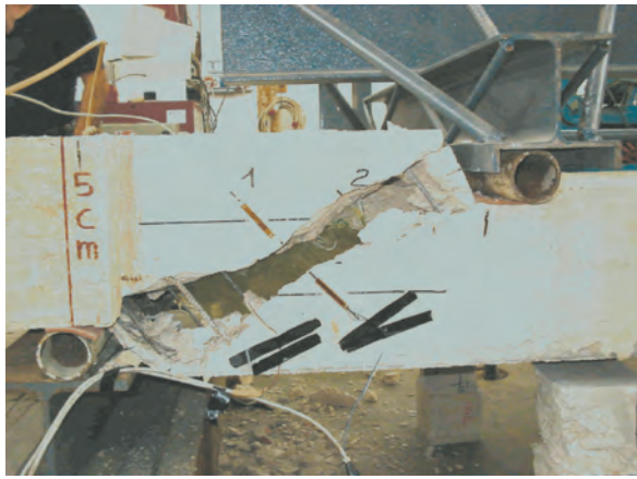
Fig. 6 - pannello n. 1 senza laterizi. Panel no. 1 without clay elements.
