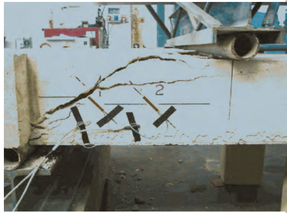
Fig. 7 - pannello n. 4 senza laterizi. Panel no. 4 without clay elements.
